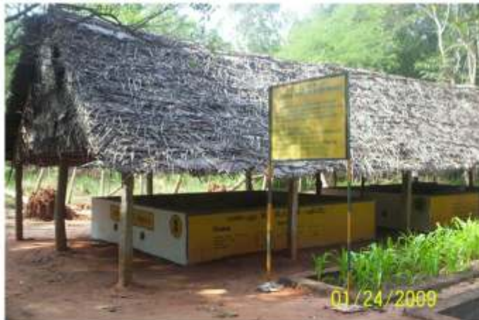
Vermicompost tank & shed / மண்புழு உரத்தொட்டி மற்றும் சிறுகுடி
